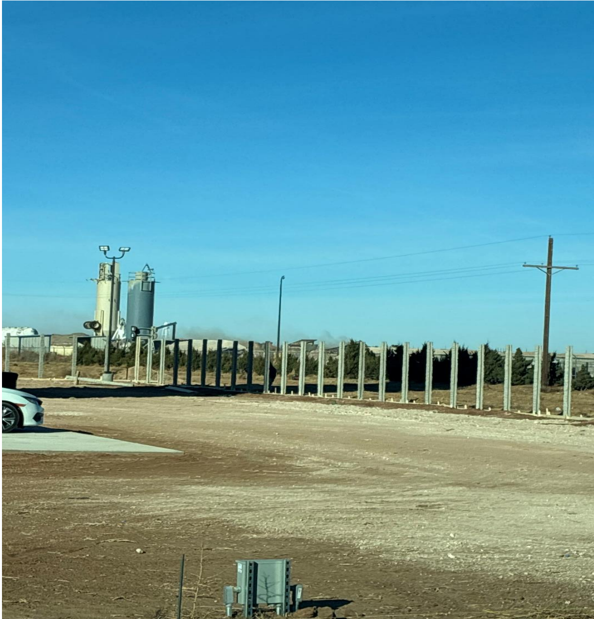
Alcove EST Progress Photos
