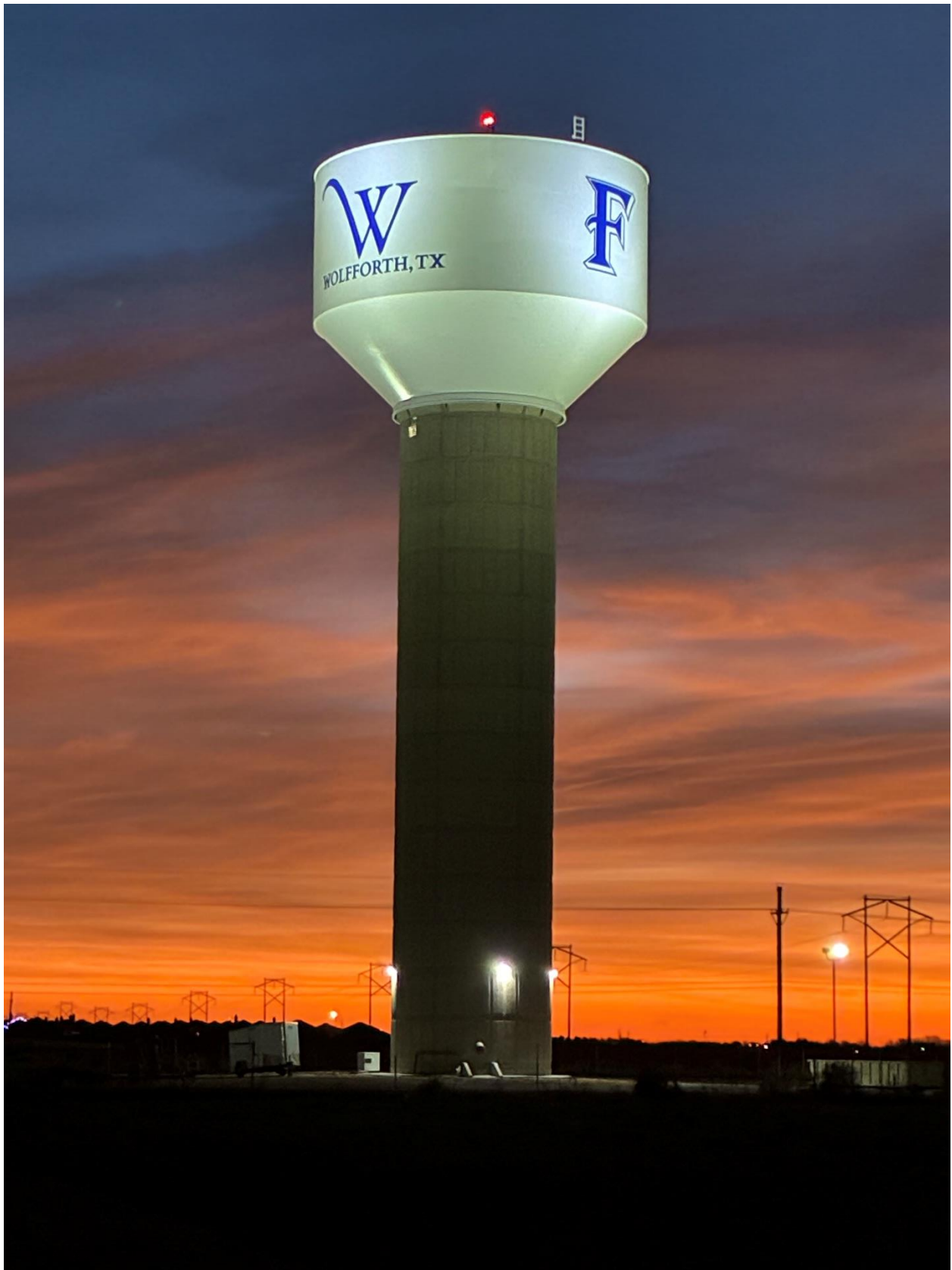
Alcove EST Progress Photo
