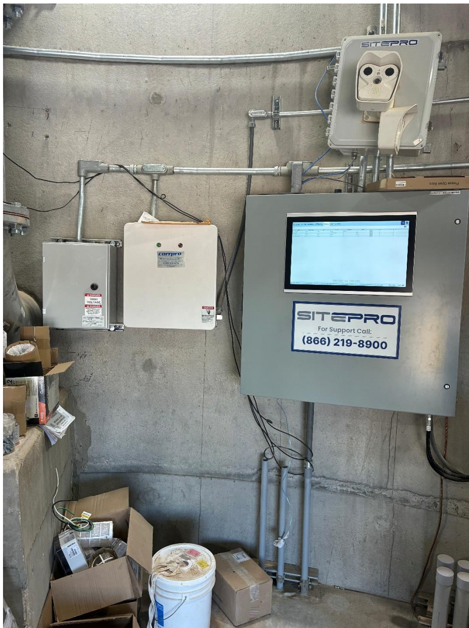
Alcove EST Construction Photos
