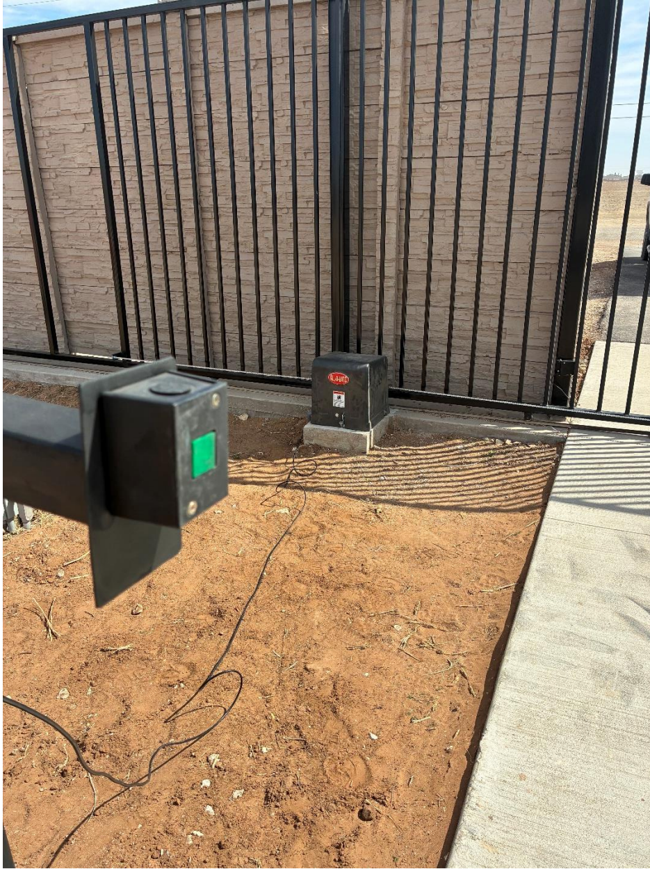
EST Progress Photos 3/3/2026
