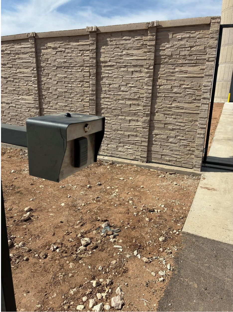
EST Progress Photos 3/3/2026
