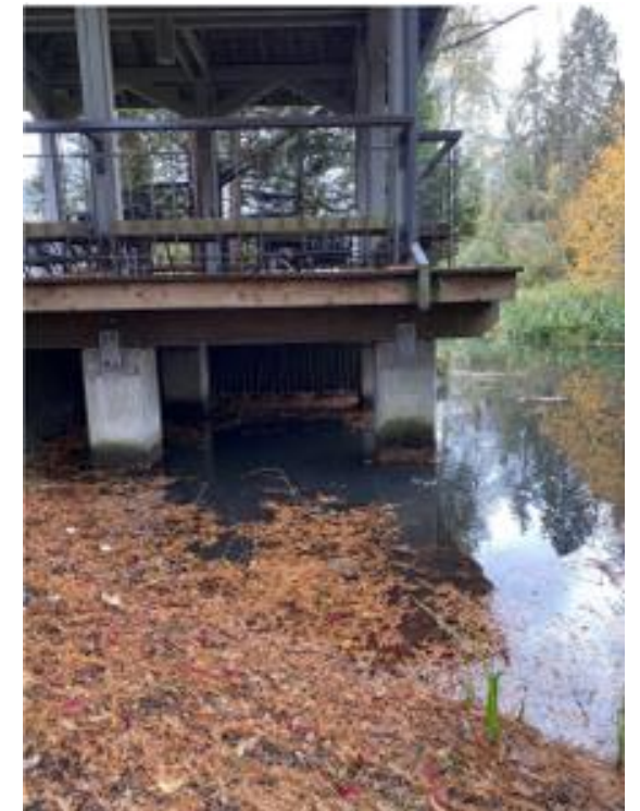
Siemens Pond Diversion (Nov 2021)
