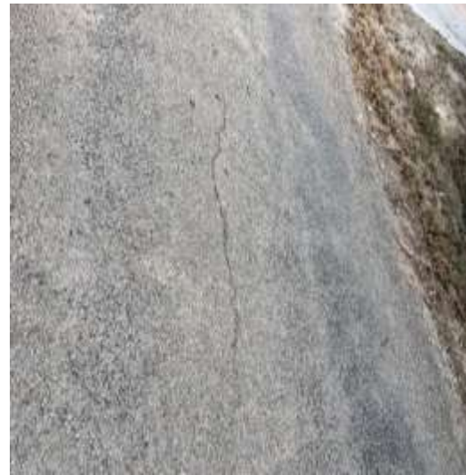
Longitudinal cracks
