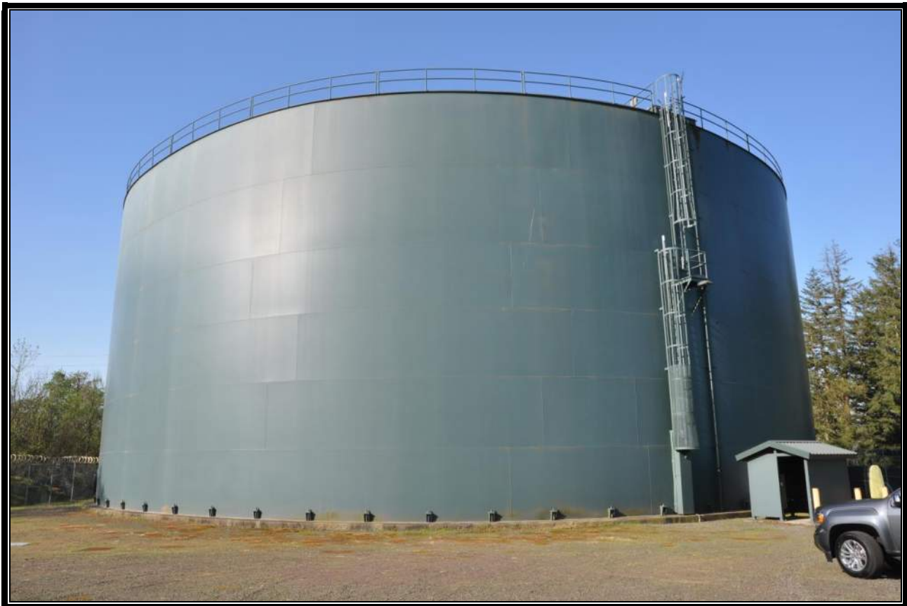
5.0 MG A2 Reservoir
