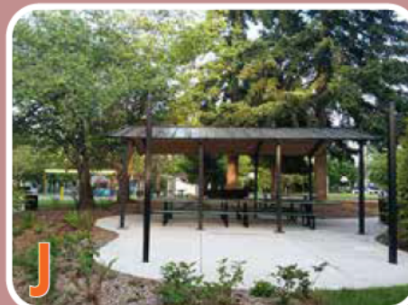
J Picnic Shelter Área para picnic techada
