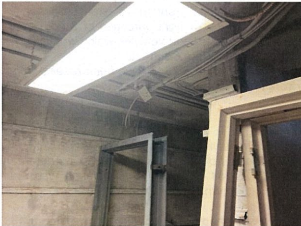
Setting Door Jambs
