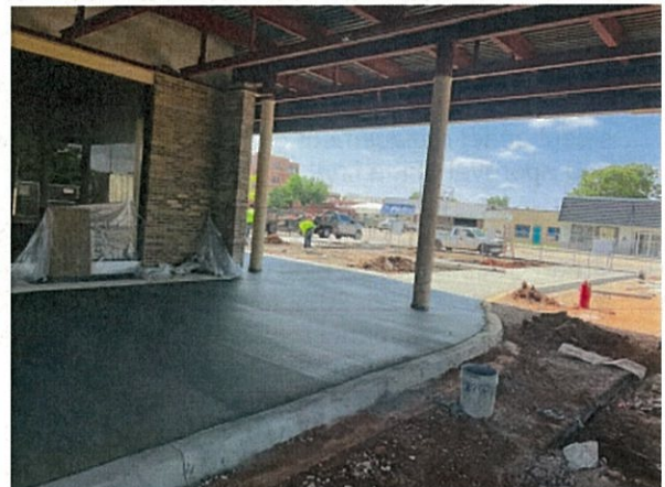
Concrete Sidewalk Pour
