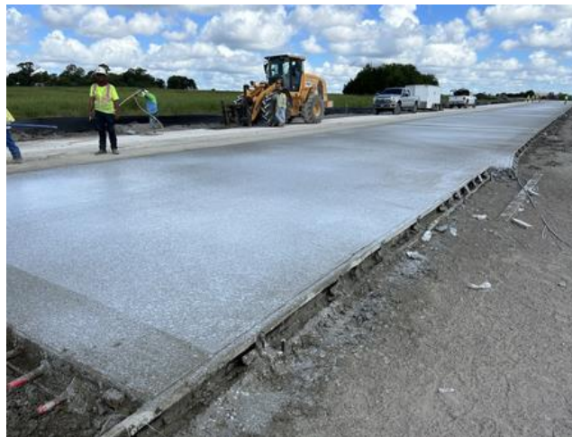
August 15, 2024 Pavement Pour
