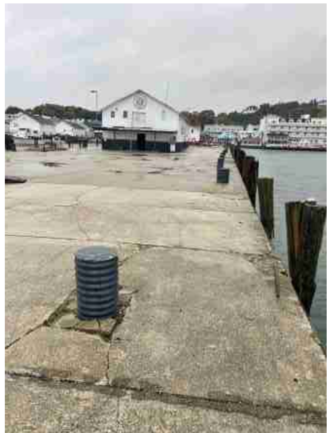
129) Bit/deck deterioration
