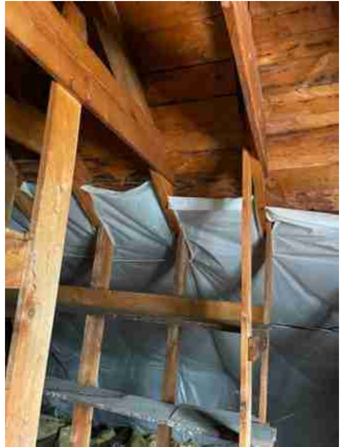
149) Warehouse roof system
