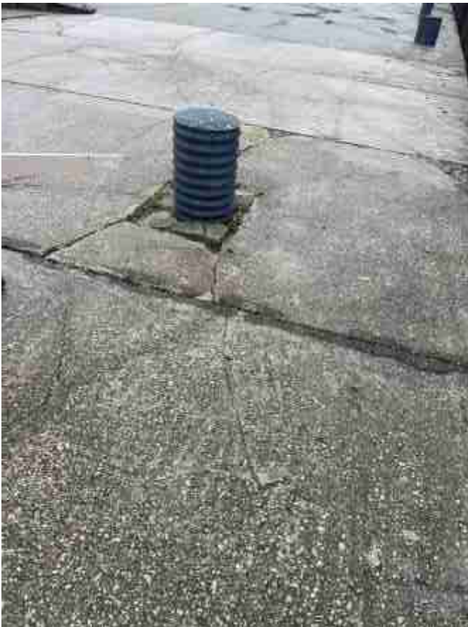
128) Bit/deck deterioration
