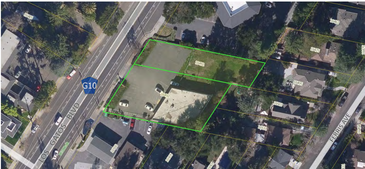
Figure D-14 Los Gatos Boulevard (Site C-6)
