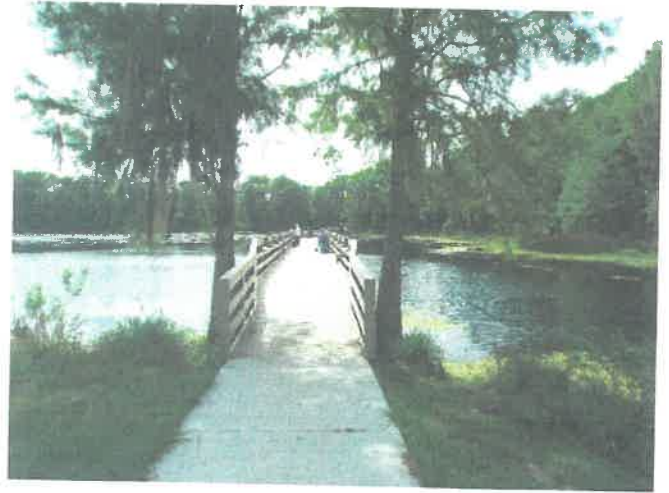
SUWANNEE LAKE PIER IN SUWANNEE COUNTY
