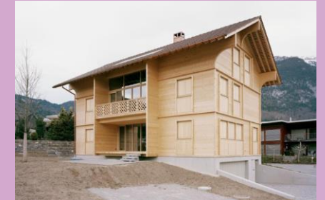
House K Seilerlinhart
