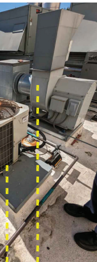
EXHAUST FAN OLD CONDENSING UNIT
