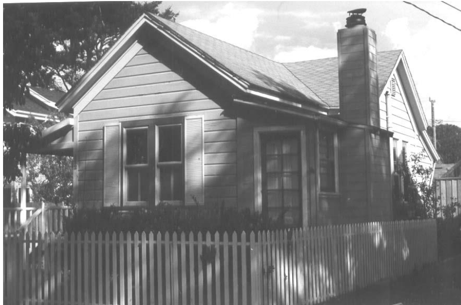
F. Maggi / Nov. 1999 / View from street
