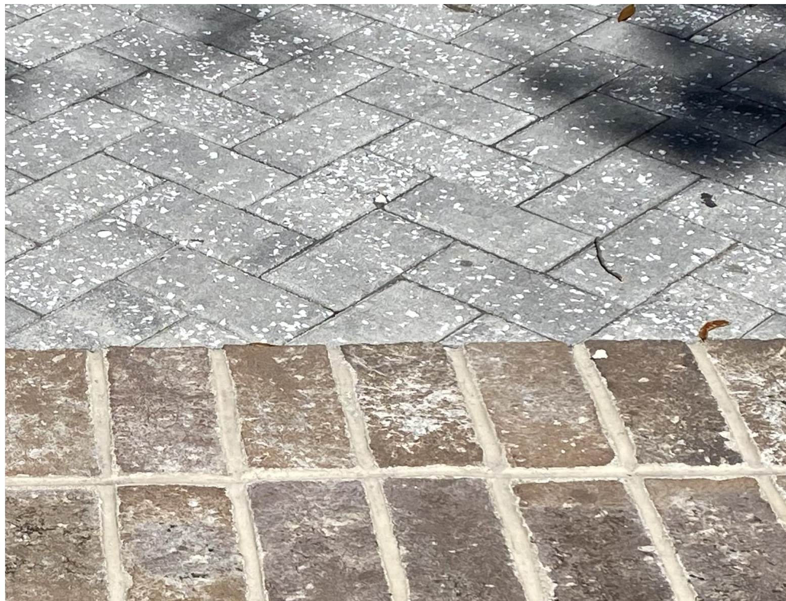
2 // L600 PERMEABLE TABBY CONCRETE PAVERS SCALE: N.T.S.
