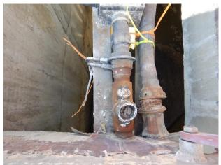
Corroded instrumentation conduit
