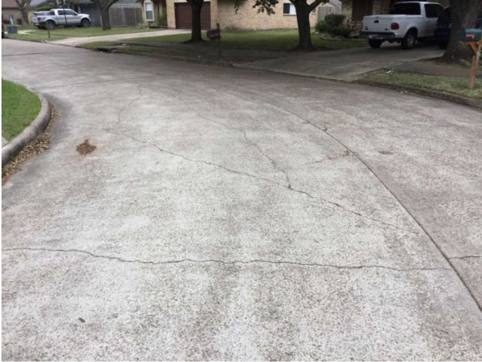
LONGITUDINAL CRACKING
